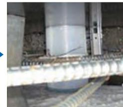
③鋼製型枠(上)と化粧型枠(下)を上部から見たところ。ポンタくんのソフトキャップが化粧枠にフィットしている。
