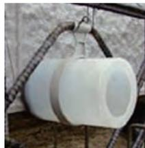
②ポンタくんのキャップ側を化粧枠に向け、スリーブホルダーを補強筋に結束線で固定。(写真は、それぞれ上と斜め上で固定した例)
