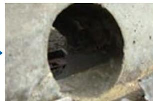
⑦鋼製型枠側の貫通穴。
