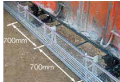
▲ラス製型枠施工写真
