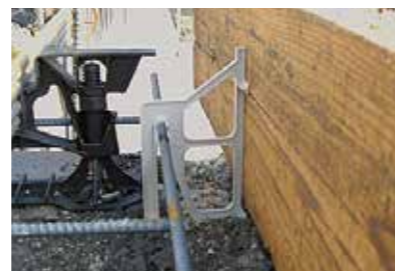
▲木製型枠施工写真
