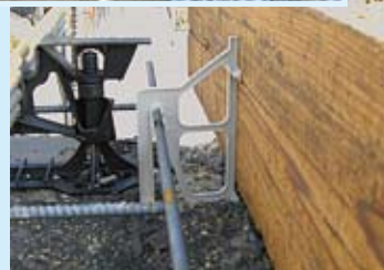
木製型枠施工写真▶
